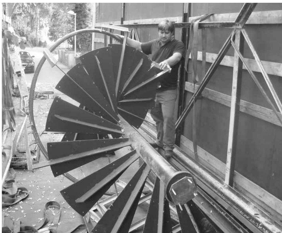
■ Die demontierte Wendeltreppe wird gerade verladen. Im Bild unser Fahrer Michail STEFAN Bilder: Hartig
