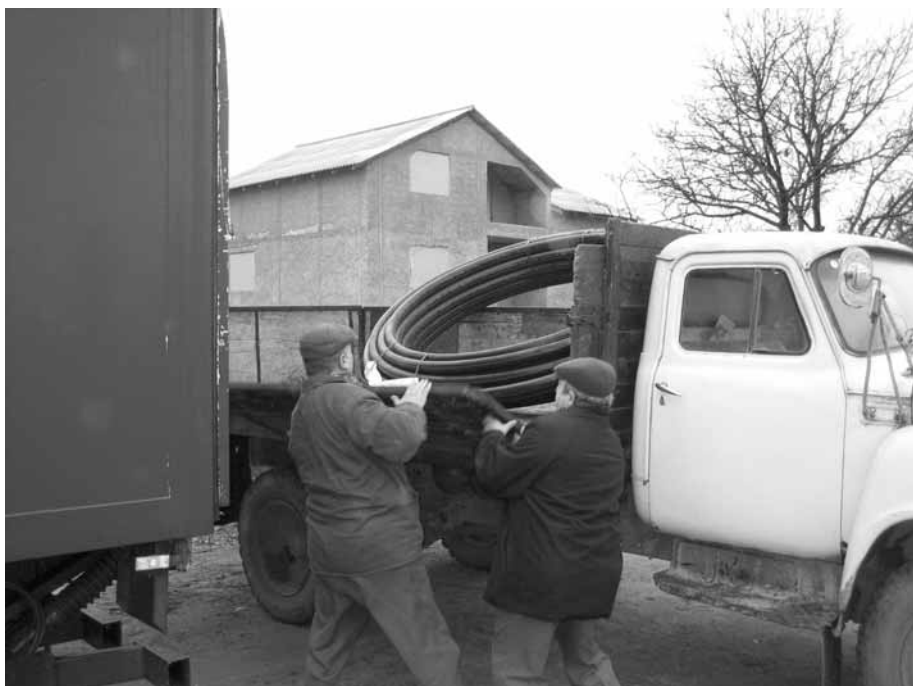
■ Anlieferung der speziellen Kunststoffwasserleitung.
