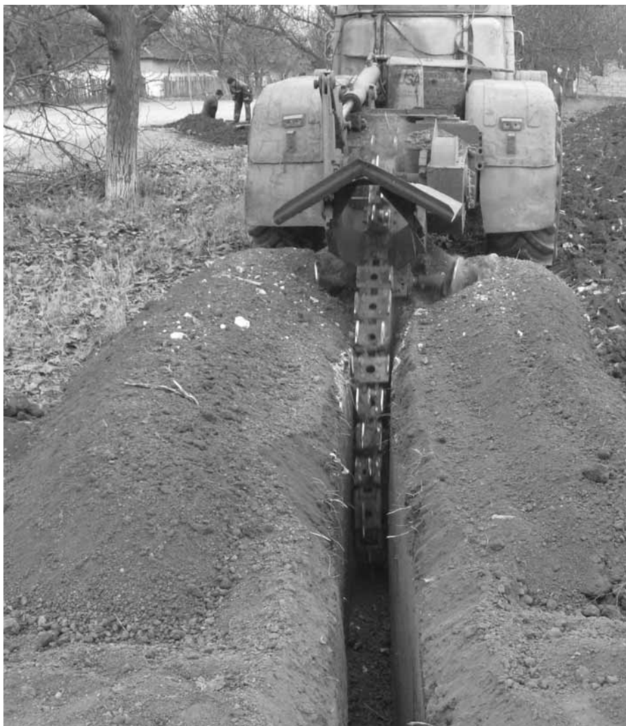
■ Der Spezialbagger beim Ausfräsen des Bodens. Gottseidank gibt es wenig Steine Bild: Hartig
