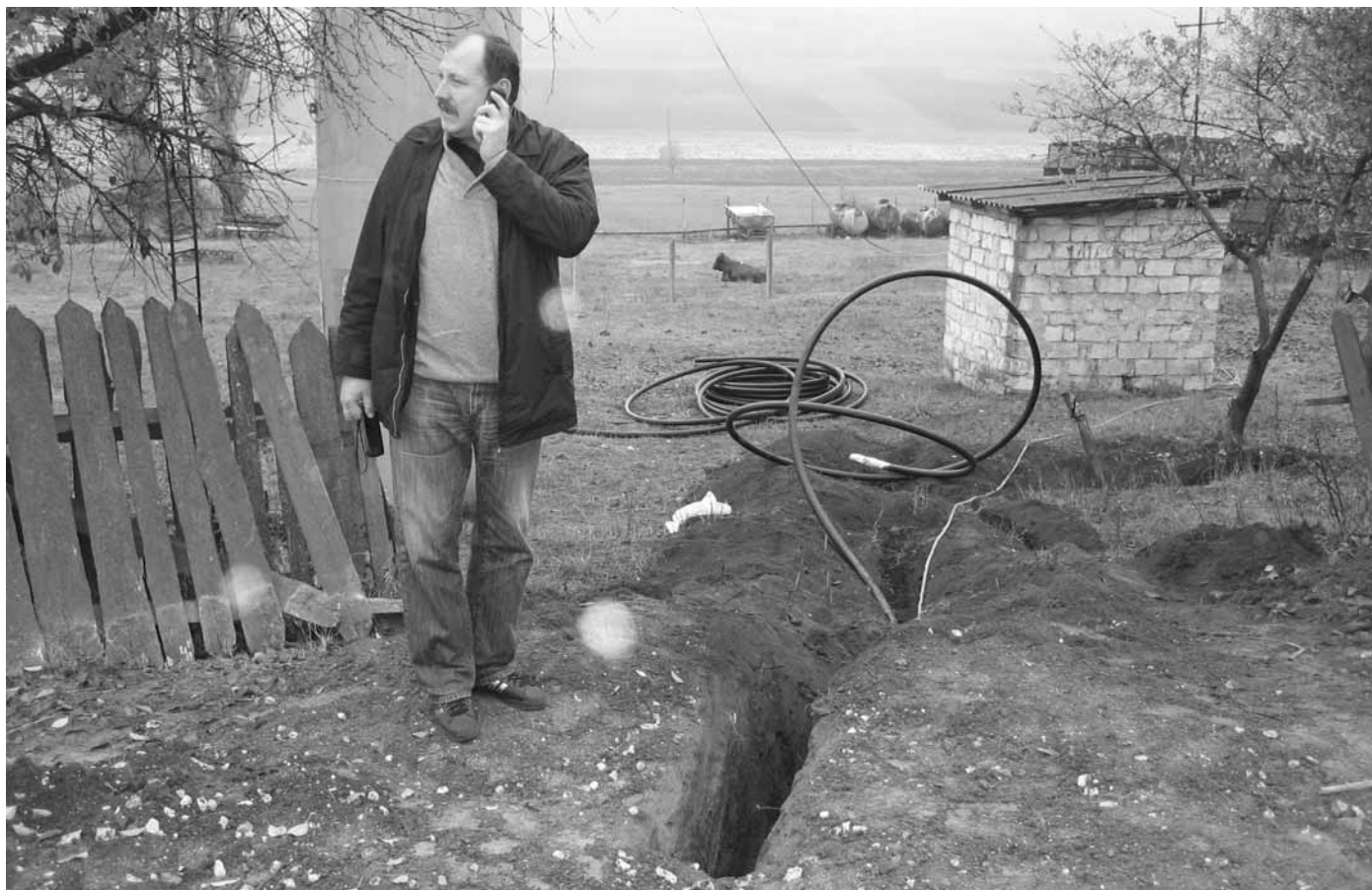
■ Jurie Banzari nimmt telefonisch Kontakt mit der etwa 2,5 km entfernten Wasserreservoirstelle auf. Auf diesem Gelände entstand die Tiefbohrung mit 230 m.
