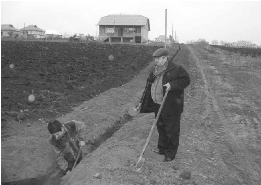
■ Im Bild rechts, der Bürgermeister von Cigirleni Ion Cat. Die Wasserleitungsgräben sind erstellt. Ein Arbeiter gräbt vorsichtig unter einer Querleitung durch.
